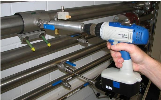
Bohren mit der CS Bohrvorrichtung
