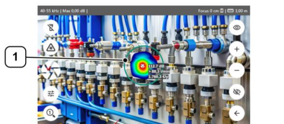
Figure 21: Fuite détectée de manière optimale (exemple)
