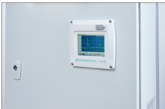
Montering i kopplingskåp
