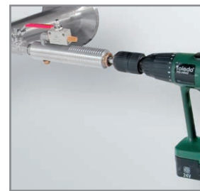
Borrning under tryck med CS borrarordning
