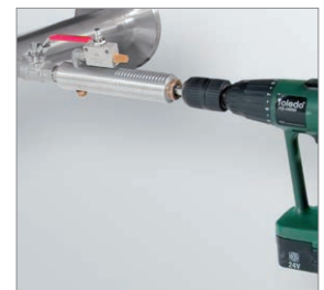
Borrning under tryck med CS borrarordning
