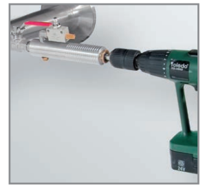
Anbohren unter Druck mit der CS Bohrvorrichtung
