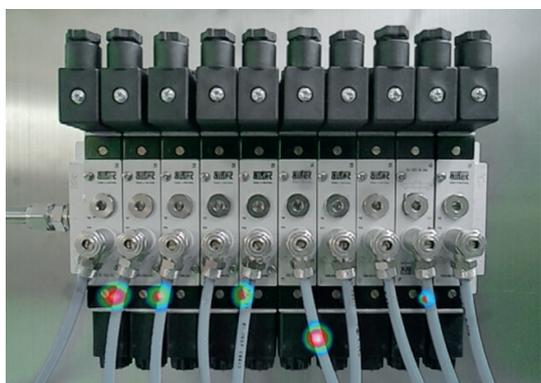
LeakCam 600 avec 64 microphones
