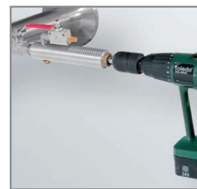
Perçage sous pression avec le dispositif de perçage CS
