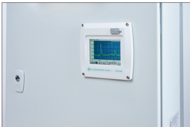
montaje en el armario de distribución
