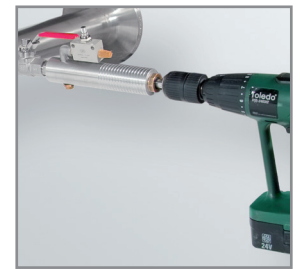
Perforazione sotto pressione con l'apparecchio di foratura CS
