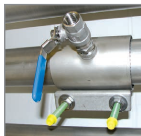
B montare la fascetta a collare comprensiva di valvola a sfera
