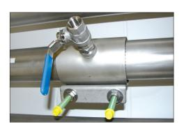
Se sul condotto esistente non è presente una sezione di misura con una valvola a sfera da 1/2", è possibile servirsi di una fascetta di raccordo per creare un punto di misura in modo rapido e conveniente. La fascetta di raccordo viene chiusa intorno al tubo e fissata con tiranti. La guarnizione integrale è a tenuta fino a 11 bar. Con un apparecchio di foratura è possibile perforare la fascetta di raccordo su tubazione esistente attraverso la valvola a sfera 1/2".
