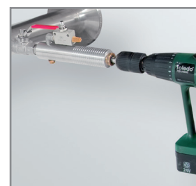
在有压力情况下使用 CS 钻孔装置钻孔
