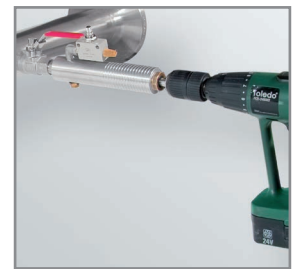
Anbohren unter Druck mit der CS Bohrvorrichtung
