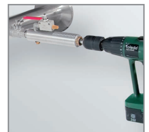
Perçage sous pression avec l'outil dédié CS Instruments
