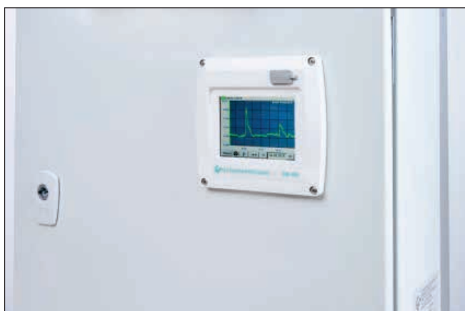
Montering i kopplingsskåp
