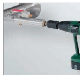
Borrning under tryck med CS borrarordning
