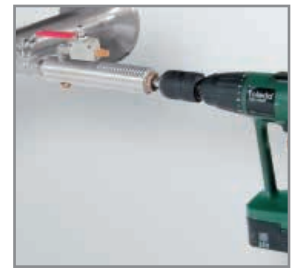
Borrning under tryck med CS borrarordning
