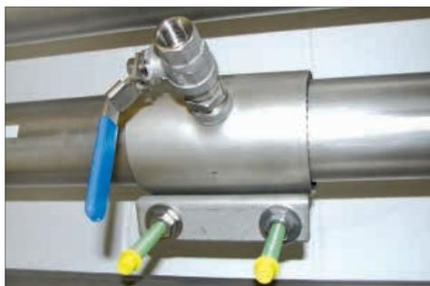
Se sul condotto esistente non è presente una sezione di misura con una valvola a sfera da 1/2", è possibile servirsi di una fascetta di raccordo per creare un punto di misura in modo rapido e conveniente. La fascetta di raccordo viene chiusa intorno al tubo e fissata con tiranti. La guarnizione integrale è a tenuta fino a 11 bar. Con un apparecchio di foratura è possibile perforare la fascetta di raccordo su tubazione esistente attraverso la valvola a sfera 1/2".
