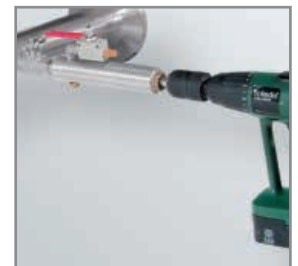
Anbohren unter Druck mit der CS Bohrvorrichtung
