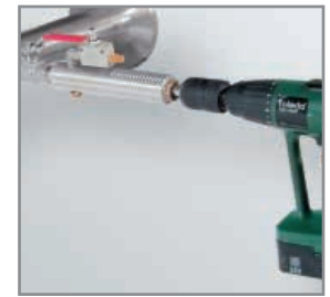
Anbohren unter Druck mit der CS Bohrvorrichtung
