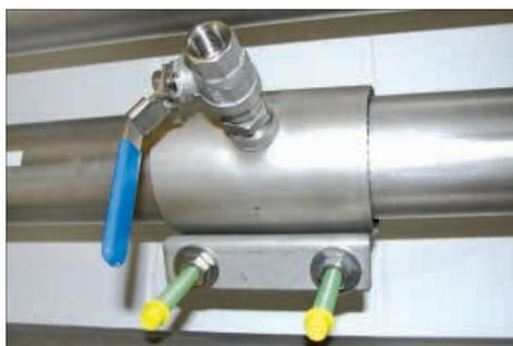
S'il n'y a pas de piquages avec un robinet à boisseau 1/2" sur les tuyauteries existantes, il est possible de créer rapidement et à peu de frais un point de mesure à l'aide de colliers de prise. Le collier de prise est embouti sur le tube et fixé à l'aide de tiges filetées. Le joint en caoutchouc enveloppant est étanche à la pression jusqu'à 11 bar. Ensuite, grâce à un outil de perçage sous pression, la canalisation existante peut être percée au travers du robinet à boisseau 1/2".
